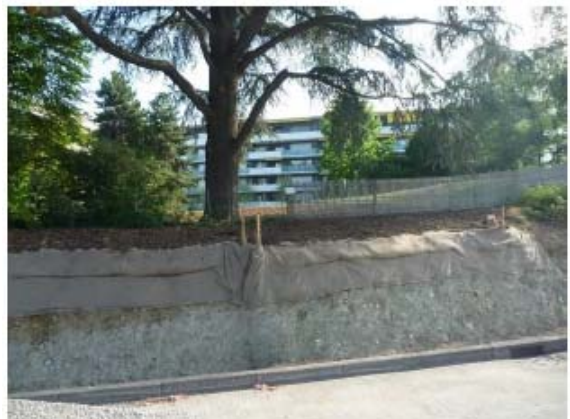
Protection racinaire d'un Cèdre, rte de Meyrin
