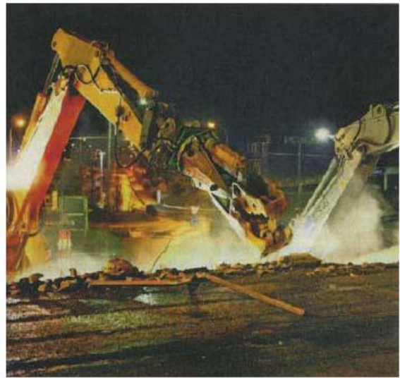
Travaux de démolition de nuit du pont de Feuillasse
