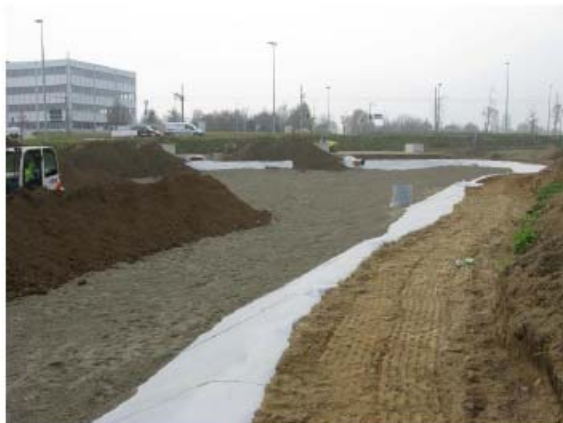
Aménagement du bassin de rétention (lot3)
