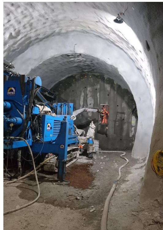
Réalisation des colonnes de jetting dans le front du tunnel (B+C Ingénieurs, janvier 2020)
