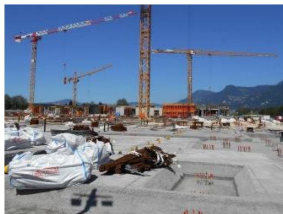
Gros œuvre, B+C Ingénieurs SA, août 2016
