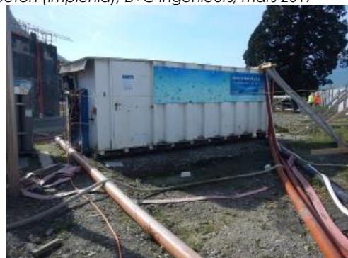
Installation de traitement des eaux réservée au gros œuvre, mai 2017
