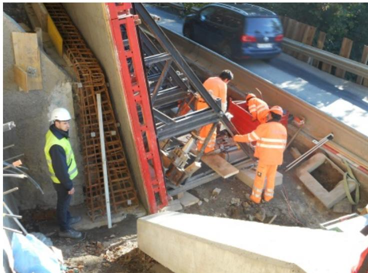
L'activité de B+C en 2015 a commencé à mi-mars, avec 5 contrôles d'implantation de murs gunités. Par la suite, 39 contrôles de coffrages des murs amont ont été réalisés.
