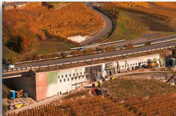
Exemple de l'assainissement d'un mur de soutènement : nouveau parement et nouveaux ancrages
